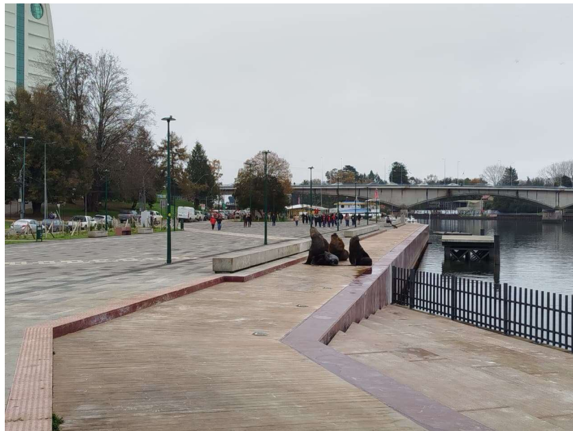
Figura 2. Registro fotográfico en Paseo Costanera. Fuente: Colección propia realizada el 4 de junio de 2025.
