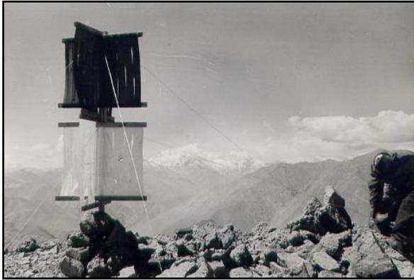
Imagen 15. Banderas de tipo doble (rojo y blanco), logran apreciarse hasta los 20 km con el Teodolito. Fuente: Sección Geodésica, IGM.
