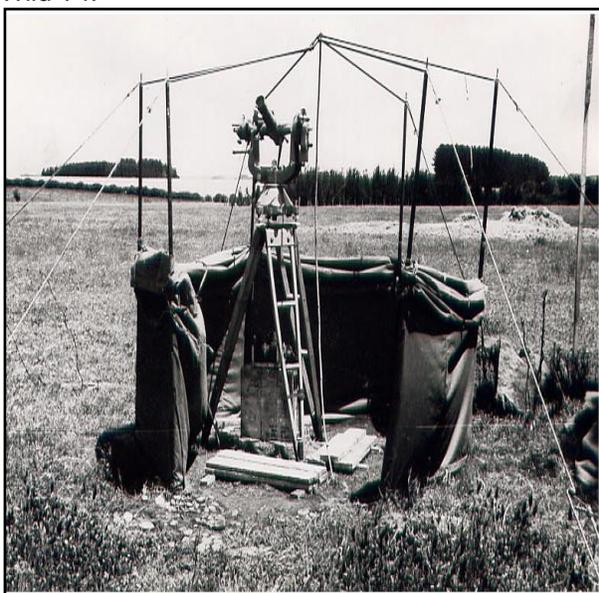
Imagen 3. Teodolito Wild T4 midiendo en base Púa Extremo Oeste, el que posee carpa abierta mostrando el T4. "Nótese los tabloncitos en el piso, para evitar las variaciones de nivelación del instrumento". Fuente: Memorias de Terreno 1964, Archivo Técnico, IGM.
